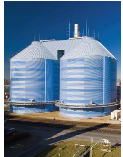
Biogasanlage InfraServ F-Höchst
